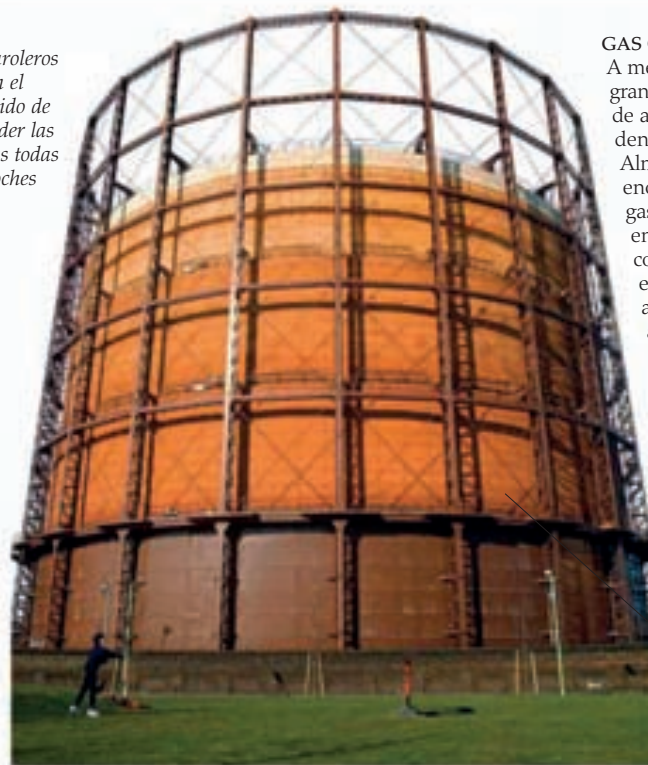
El gasómetro se «hundía» a medida que se consumía el gas
