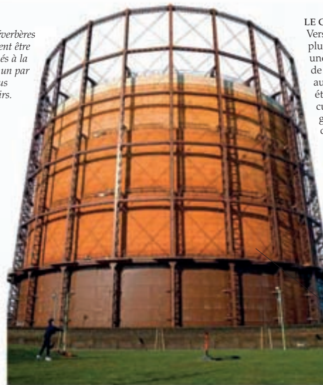
Les gazomètres s'enfonçaient dans le sol à mesure que la quantité de gaz à l'intérieur de la cuve diminuait.
