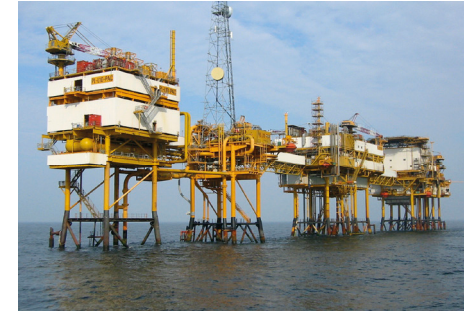
Het L10-A gasproductiecomplex, het oudste productieplatform in het Nederlands deel van de Noordzee (1975)
