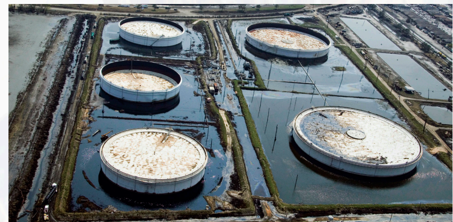
Een overstromde olie-installatie in de VS na de orkaan Katrina in 2005
