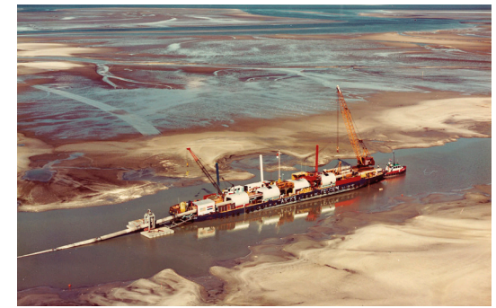
Aanleg van de NGT-pijpleiding in het Waddengebied
