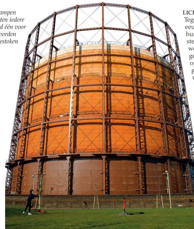
Gashouders daalden in de grond naarmate de hoeveelheid gas die ze bevatten afnam
