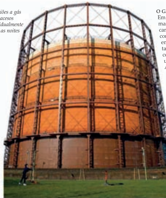
Os enormes gasômetros afundavam no solo à medida que o gás era consumido
