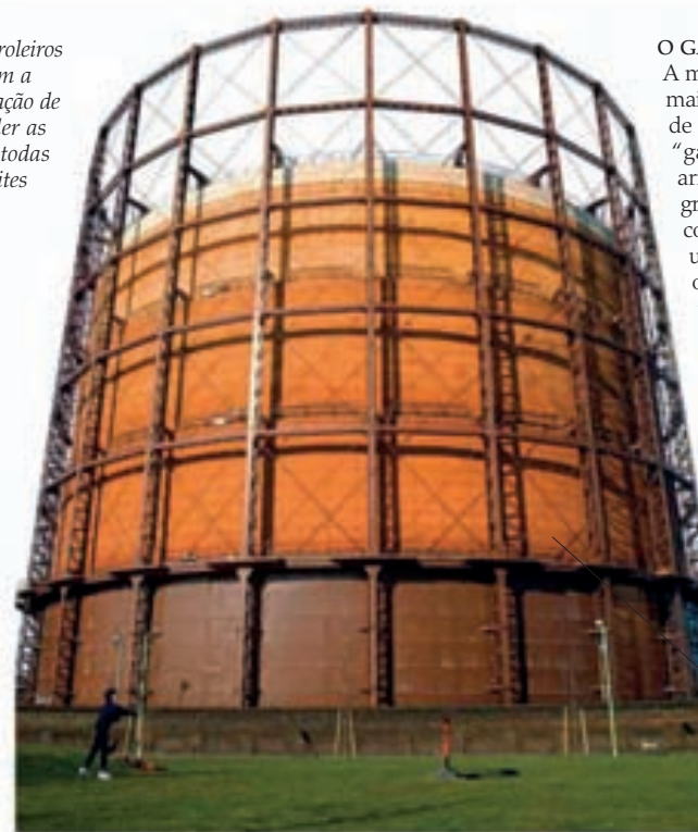
Os enormes gasómetros "afundavam" à medida que o gás era consumido
