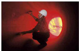
在俄罗斯正在检查天然气管道的工人
